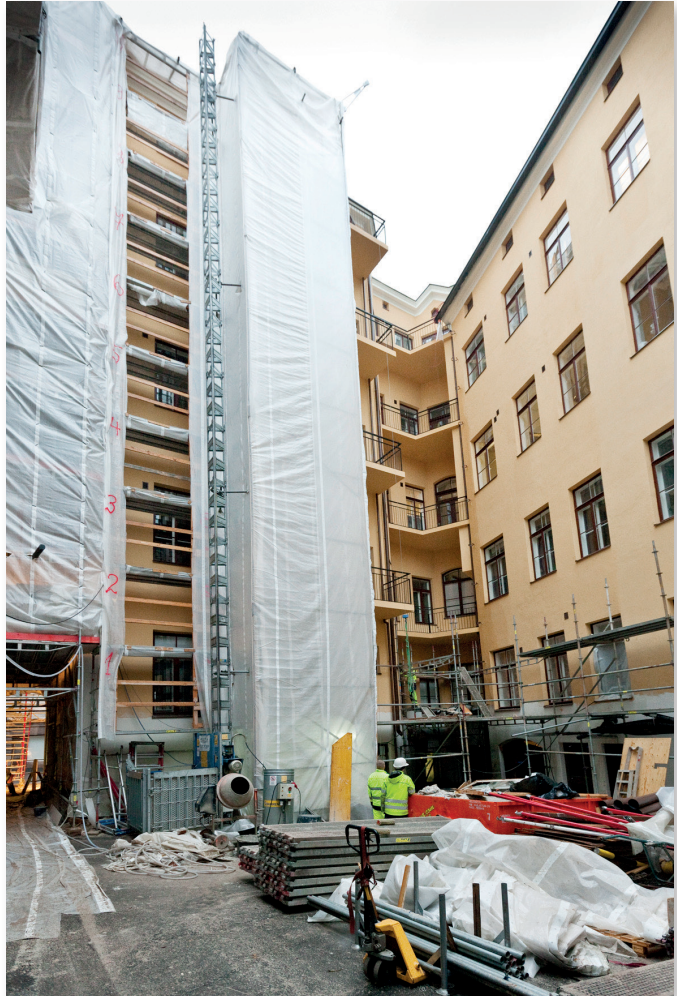
Kuva 22. Rakennuksen sääsuojaus julkisivuremontin aikana. Kuva: Pentti Hokkanen / YHA Kuvapankki
