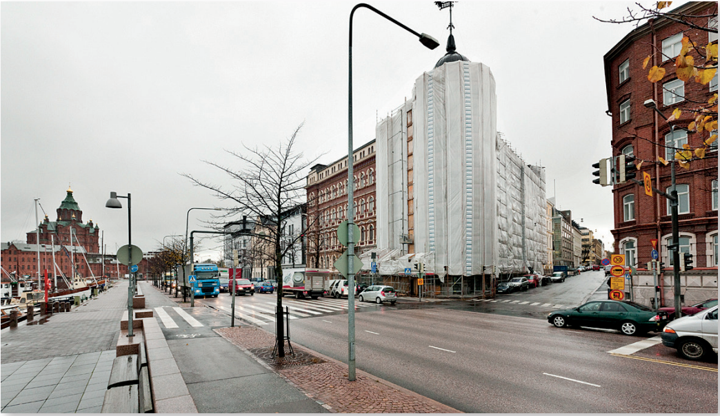
Kuva 22. Rakennuksen sääsuojaus julkisivuremontin aikana. Kuva: Pentti Hokkanen / YHA Kuvapankki
