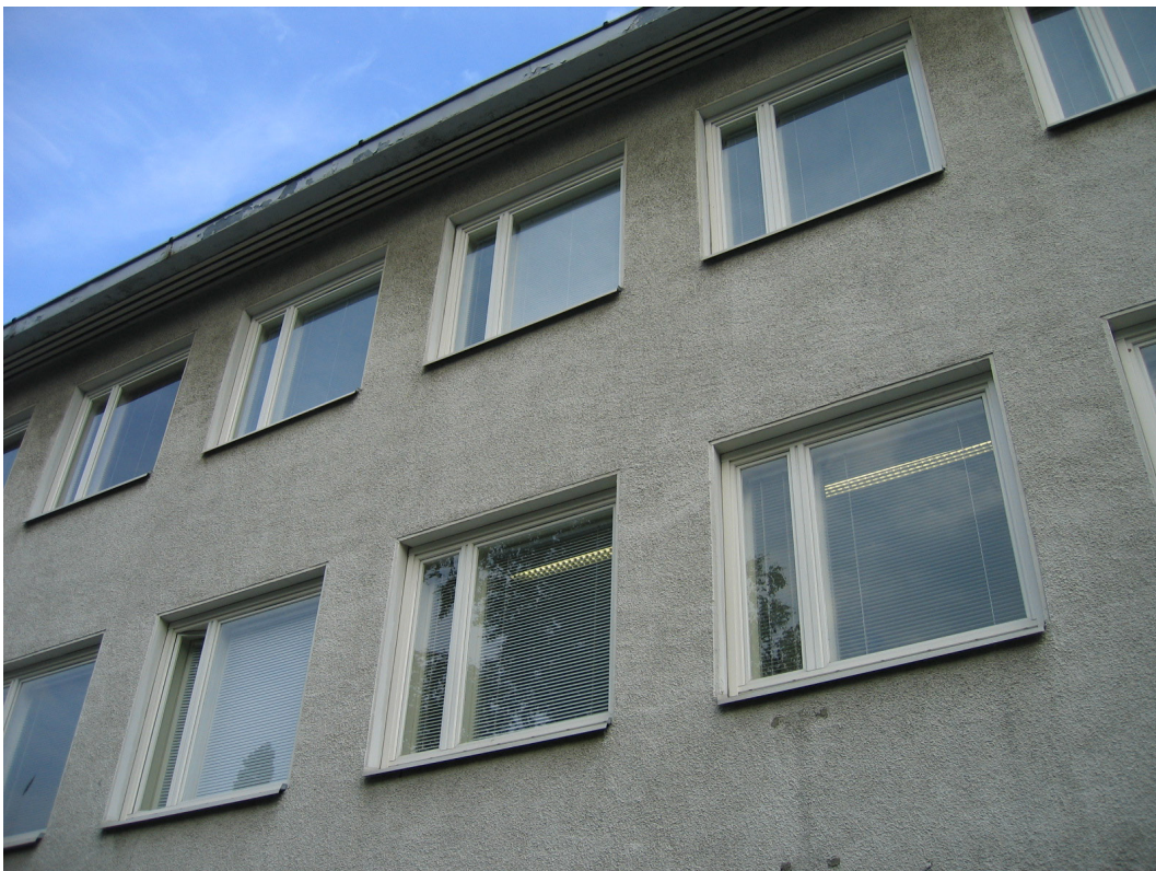
1950-luvun rakennuksen yksinkertaista ikkunajakoa ja sovitusta rapattuun julkisivupintaan.
