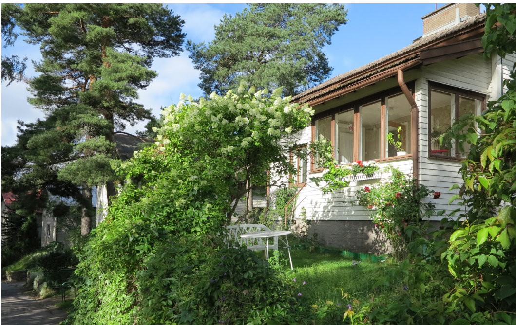
Uusitut ikkunat 1940-luvun jälleenrakennuskauden pientalossa.
