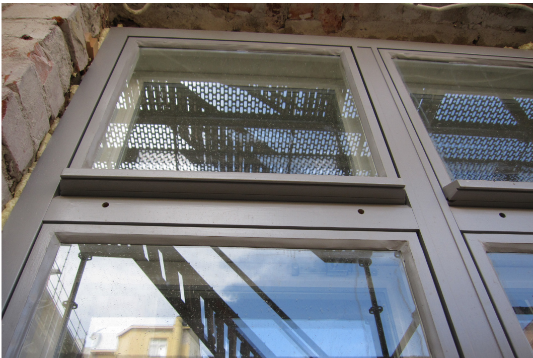
Sisään-sisään aukeavaksi muutettu uusi puuikkuna 1920-luvun rakennuksessa.
