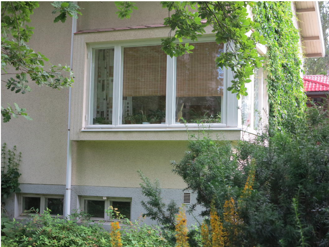
1940-luvun pientalon alkuperäinen erkkeri-ikkuna ja kulmauksen siro peiterimoitus on tyypillinen aihe funktionalismin ajan pien- ja kerrostaloissa.
