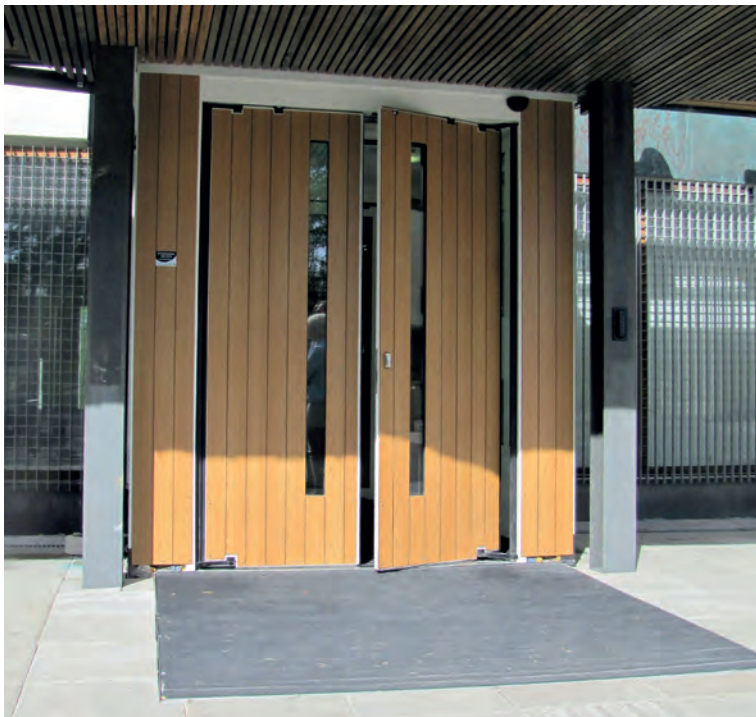
I samband med renovering kan man använda smala dubbeldörrar som öppnas automatiskt och inte kräver mycket plats i färdriktningen.
