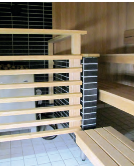
Bastuaggregatet skyddas med ett lika högt skyddsräcke.
