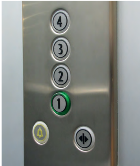
Knapparnas reliefmarkeringar avviker från bakgrunden som en tydlig ljushetskontrast. Knappen för utgångsplanet har en annan färg än de övriga och är upphöjd.
