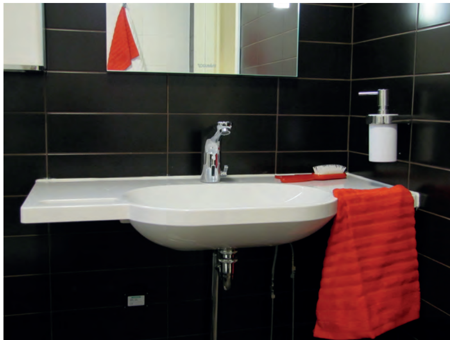
Tvättställ försett med stödräcken.
