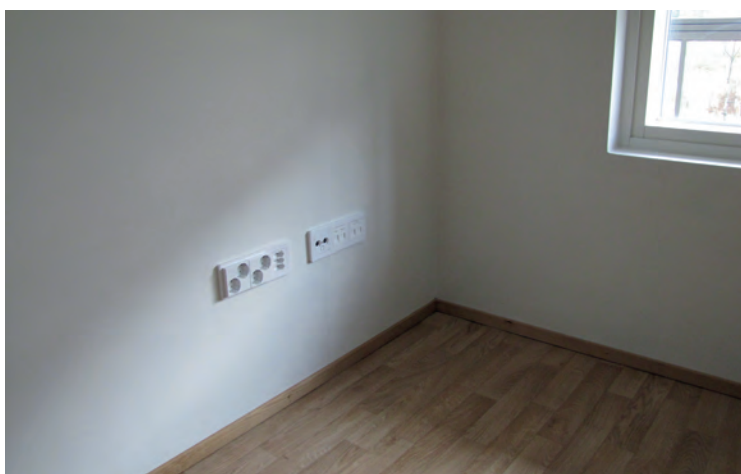
Eluttagen placeras så att de kan användas också från en rullstol.
