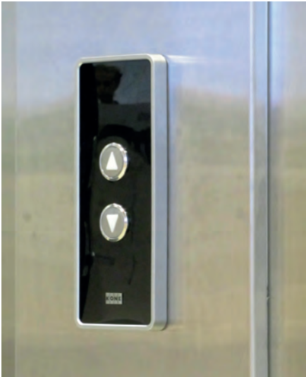
Hissens anropsknappar avviker från panelen och panelen från bakgrunden.
