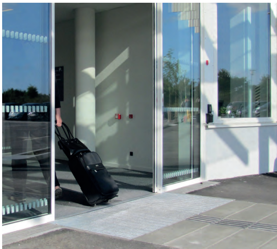
Gallret framför dörren är nedsänkt i avsatsen så att det inte bildar en svårpasserad nivåskillnad.
