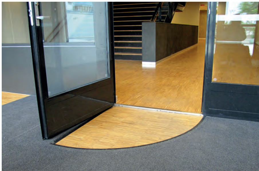
Säkerhetsavståndet framför en dörr som öppnas mot användaren markeras på förbindelseledens yta med ljushets- eller materialkontrast.
