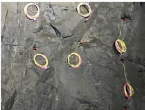
Kuva 16: Austin Powderin hybridisytytysjärjestelmän osat (kuva: Sannerud, 2021).
