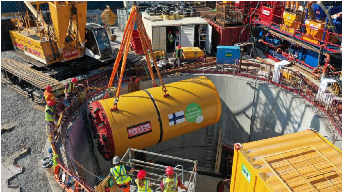
Kuva 6: Noin 70 tonnia painava mikroluokan TBM-tunnelipora laskettiin aloituskaivantoon Turussa 2021 (Päiviö, 2020).
