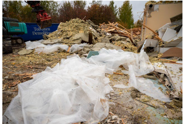
Kuva 9. Höyrynsulkumuovia sekoittuneena eristeisiin Tasanteen päiväkodilla. (Tuomas Laitinen 2022.)
