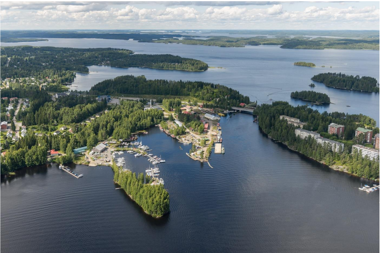
Valtakunnallisesti arvokas Laitaatsillan telakan kulttuuriympäristö.
