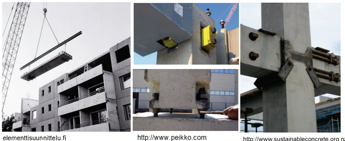
Kuva 10. Myös betonirungon osia voidaan käyttää uudelleen, etenkin jos liitokset suunnitellaan nykyistä helpommin purettaviksi.
