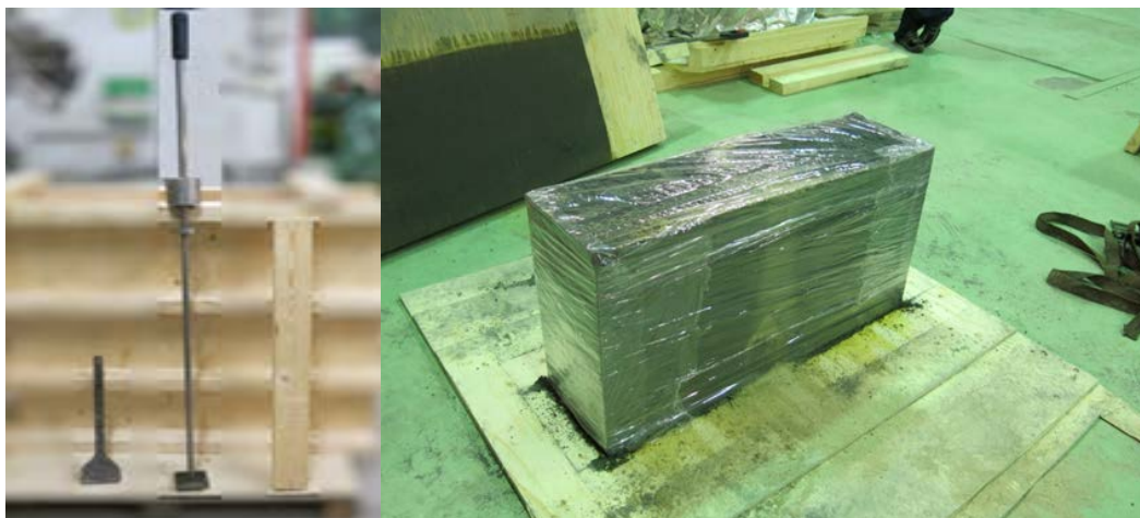
Kuva 18. Vasemmalla: Demonstraatiomuurirakenteen tiivistämiseen käytetyt työvälineet. Vasemmalla puolella olevaa tiivistyssauvaa ei käytetty lopullisessa demonstraatioissa, vaikka alustavissa kokeissa tiivistäminen sauvalla onnistui myös erinomaisesti. Oikealla: Muotista purettu muurirakenne suojattiin muovikalvolla liian vedenhaihtumisen estämiseksi ja hydraataatiotuotteiden muodostumisen mahdollistamiseksi.
