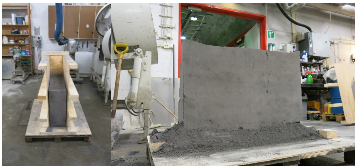
Kuva 36. Kuva muotin purkamisesta välittömästi valun jälkeen ja lopullinen rakenne. Muuri-rakennedemonstraatio 1:n massan vesimäärä oli liian pienen.
