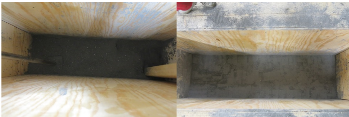
Kuva 35. Kuva RE-massan tiivistämisestä muottiin ja tiivistetty massakerros.
