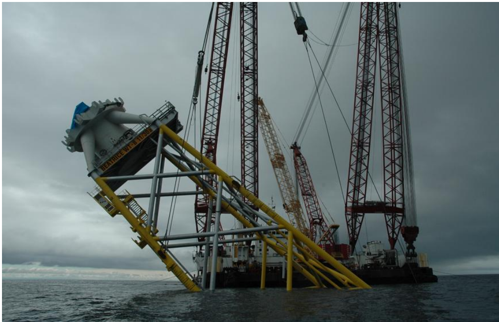
Kuva 3. Repower 5M -perustuksien pystytys http://www.repower.de/index.php?id=237&L=1
