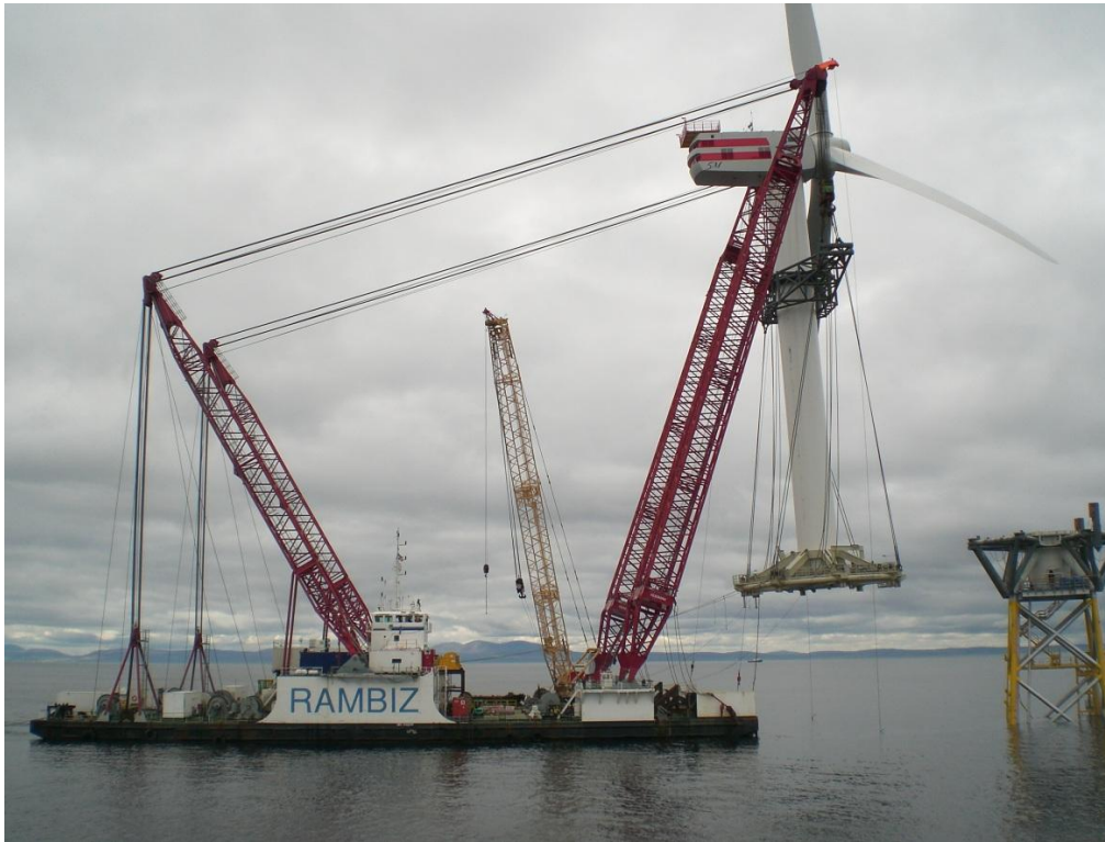
Kuva 4. Repower 5MW -turbiinin asennus http://www.repower.de/
