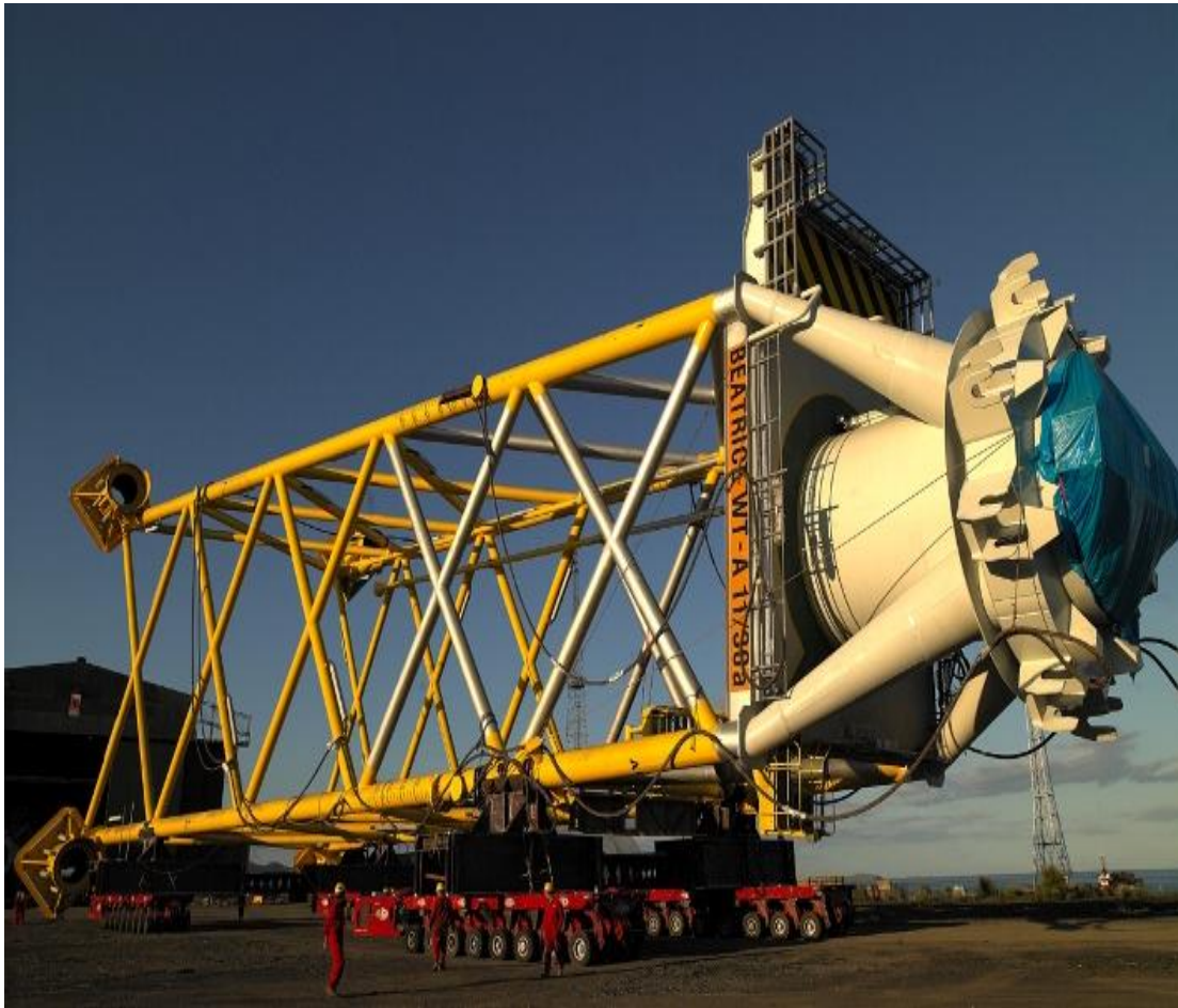
Kuva 2. Repower 5M -perustukset http://www.repower.de/index.php?id=237&L=1
