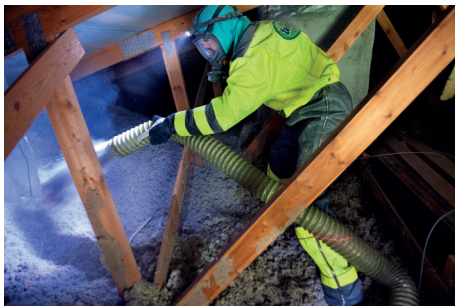
Kuva 42. Yläpohjan lisälämmöneristystä puhallusvillalla (kuva Termex-Eriste Oy).
