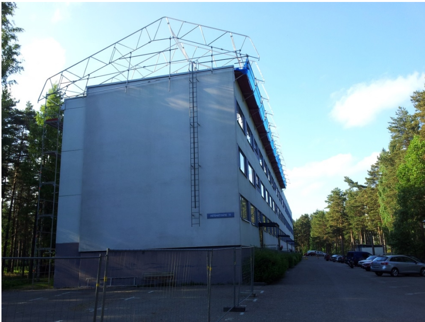
Kuva 76. Kerrostalon kattosuojauksen rakentamisvaihe.
