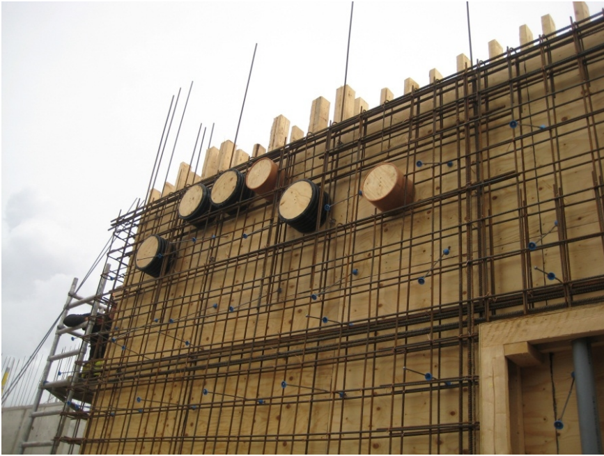
Kuva 5. Suurten läpivientien tiivistäminen läpivientikappaleilla.
