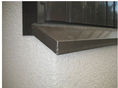
Kuva 9. Esimerkkejä suojapellityksistä. Yllä sisäänkäyntikatoksen räystääspellityksen nurkka, keskellä nurkkapilasterin suojapellitys (vasen) ja läpivientejä kallistettuna ulospäin julkisivusta (oikea) sekä alla ikkunapellin pään liittyminen julkisivuun (vasen) ja ulkonevan julkisivun suojapellitys peltiverhouksen alapuolella (oikea).
