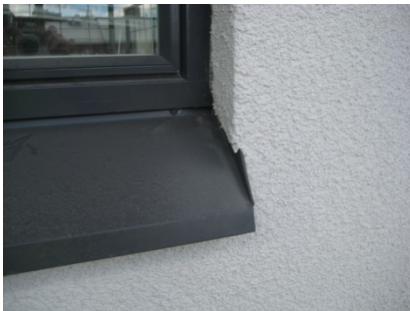
Kuva 9. Esimerkkejä suojapellityksistä. Yllä sisäänkäyntikatoksen räystääspellityksen nurkka, keskellä nurkkapilasterin suojapellitys (vasen) ja läpivientejä kallistettuna ulospäin julkisivusta (oikea) sekä alla ikkunapellin pään liittyminen julkisivuun (vasen) ja ulkonevan julkisivun suojapellitys peltiverhouksen alapuolella (oikea).
