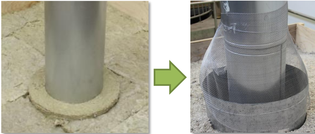
Vasemmallä alkuperäinen läpivientirakenne. Oikealla läpivientirakenne lisäeristuksen ja tarvittavien muutosten jälkeen.
