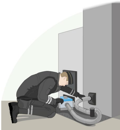
Kuva 19 Hormin tiiveyskoe
