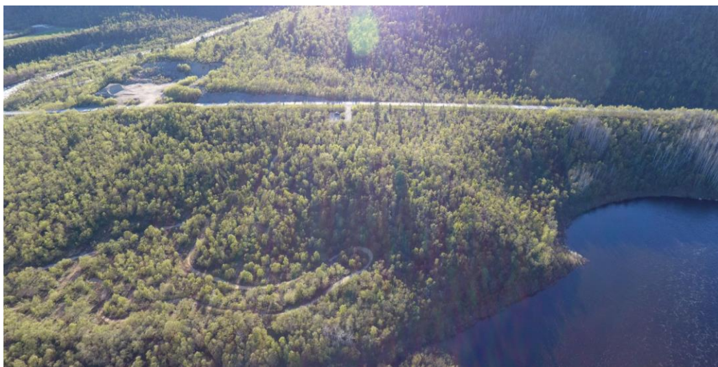
Figur 3. Dronebilde over planområdet tatt fra øst mot vest. Planområdet i forgrunnen. Grustaket på vestsiden av E6 vises godt i dette bildet. Foto: Nordlys Drone.
